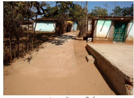
ग्राम पंचायत में सड़क निर्माण
